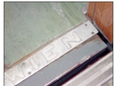
Absicherung mit beweglicher Schwelle
